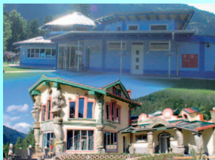
Europas unglaublichste Sanitärgebäude!
